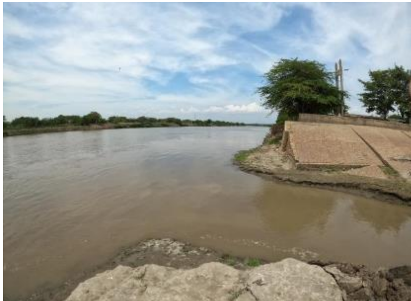
Fotografía 3.2.4-3 Canal de Dique en compuertas Porvenir
